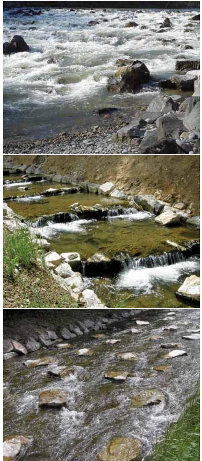
Fig. 2 Diversi sistemi costruttivi per le rampe di blocchi. In alto: rampa a posa classica sull'Emme presso Burgdorf (BE; foto: Thomas Berchtold). Al centro: rampa strutturata sciolta con struttura di bacino e traverse sullo Staffeleggbach (AG). In basso: rampa non strutturata sciolta sull'Aabach a Seengen (AG). Foto: Denise Weibel
