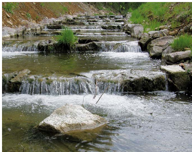
Fig. 4 Succession de bassins séparés par une chute sur le Staffeleggbach (AG). Ce phénomène doit être évité sur les cours d'eau où vivent des chabots. Photo: Denise Weibel
