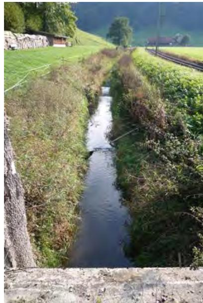
Abb. 30: Die revitalisierte Strecke (links) und kanalisierte Strecke (rechts) des Sandbachs.
