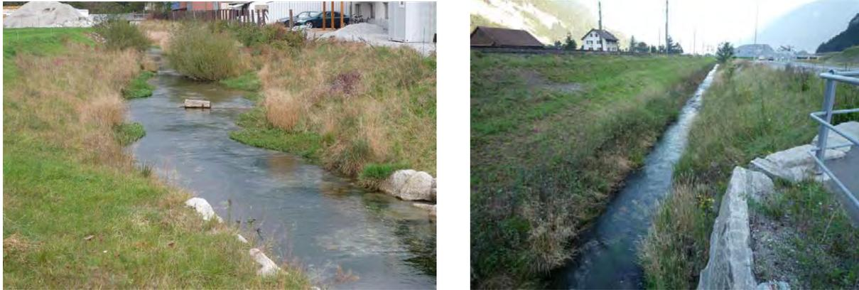
Abb. 36: Die revitalisierte Strecke (links) und kanalisierte Strecke (rechts) des Walenbrunnens.
