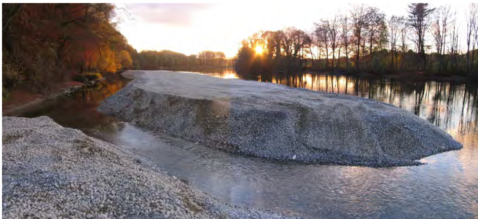
Abb. 2: Kiesschüttung an der Aare in Aarwangen (Photo: Flussbau AG)
