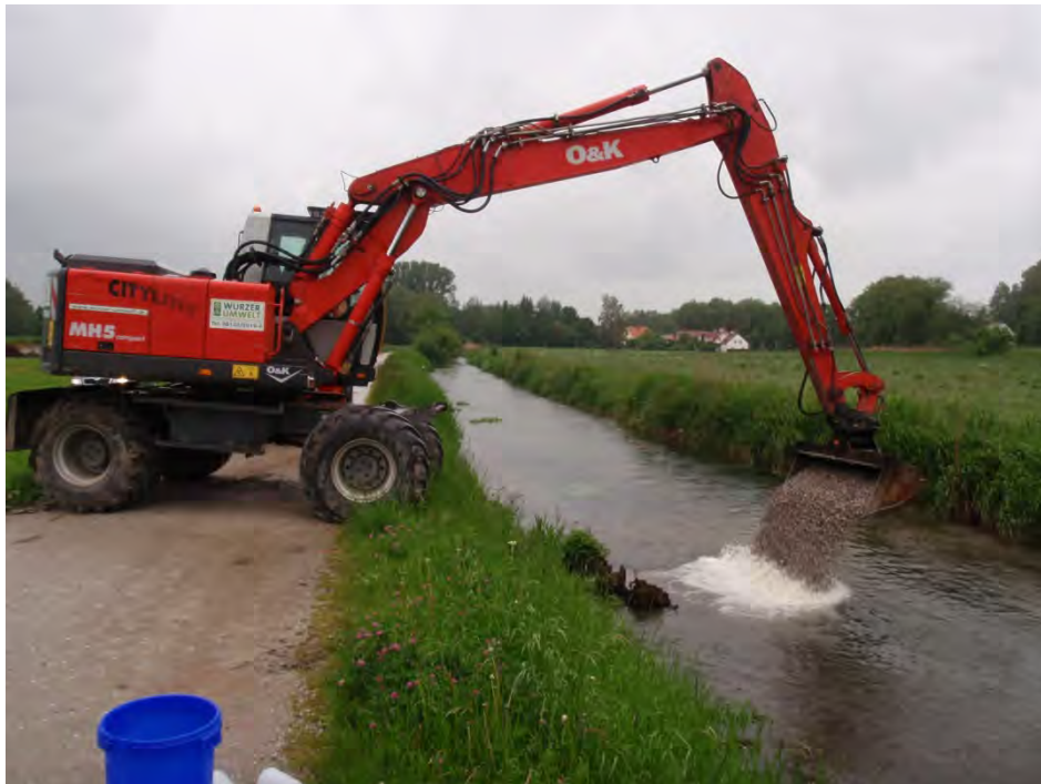
Abbildung 1: Kleinräumige Kiesschüttung in einem Bach in Bayern (©TUM-aquat.systembiol.)
