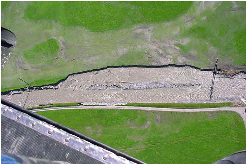
Abb. 1.3: Spontane Aufweitung durch Seitenerosion an der Engelberger Aa (Fluss-Km 12.35-12.95) beim Hochwasser von August 2005. (Foto: Niederer & Pozzi).
