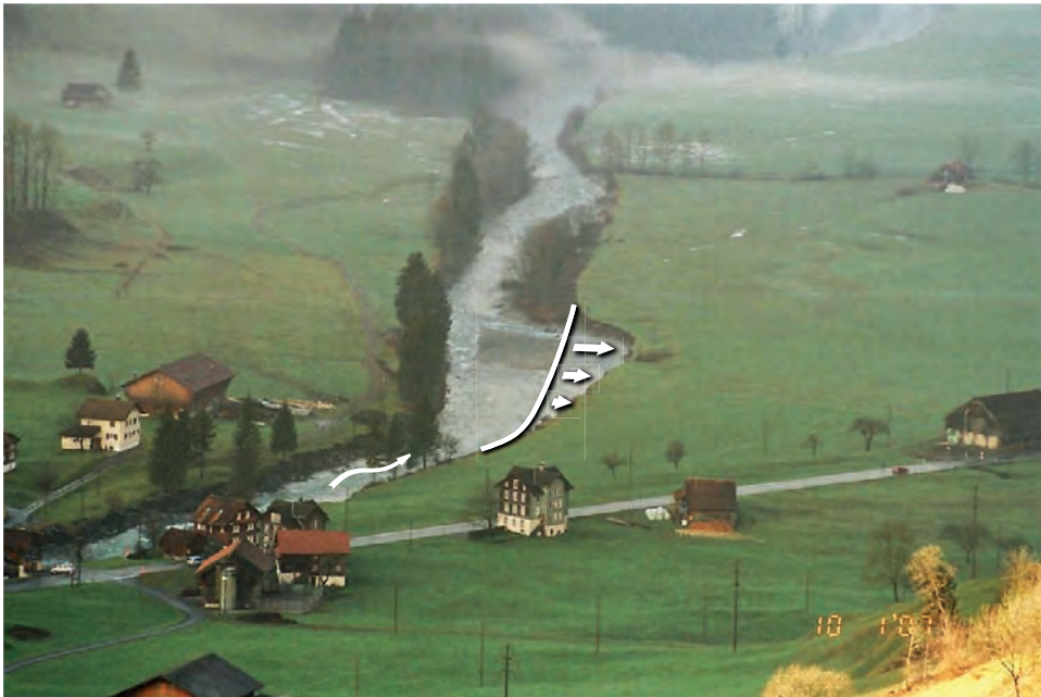
Abb. 8.21: Seitenerosionsstelle an der Muota (Fluss-km 13.1 – 13.3). Der ursprüngliche Uferverlauf ist weiss markiert (Bild: Beffa Tognacca GmbH) (Aus WYRSCH 2007).
