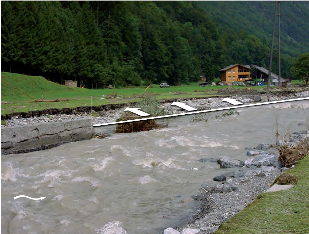
Abb. 8.17: Seitenerosionsstelle Engelberger Aa bei km 13.85 – 14.05. Der ursprüngliche Uferverlauf ist weiss markiert (Bild: Niederer+Pozzi Umt AG, September 2005) (WYRSCH 2007).
