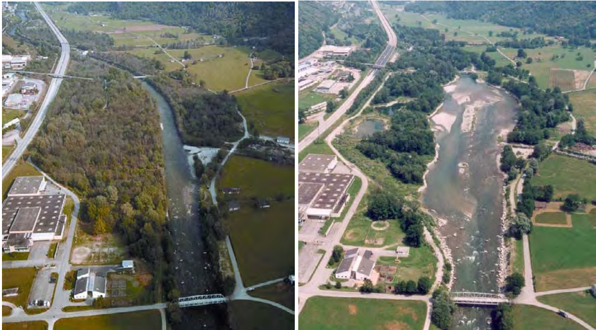
Abb. 1.1: Kanalisierte Moesa 1999 (links) und aufgeweitete Flussstrecke 2002 (rechts) bei Grono (Foto: Tiefbauamt Graubünden).
