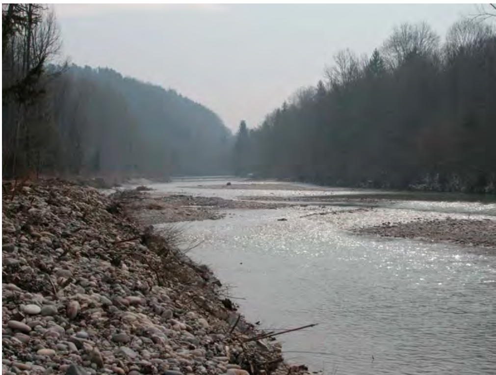
Abb. G.4: Aufweitung Winterseyschache an der Emme. Das Foto wurde nach dem Hochwasser vom August 2005 aufgenommen.
