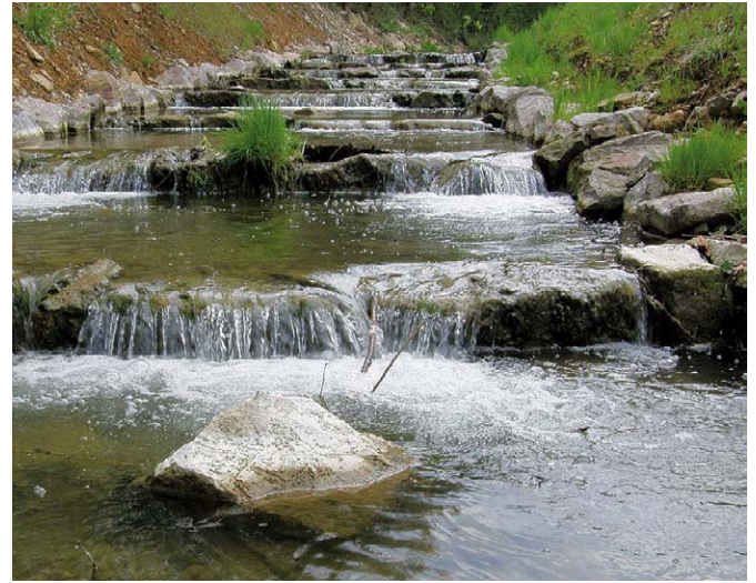
Abb. 4 Vertikale Abstürze bei Querriegeln am Staffeleggbach (AG). In Fließgewässern, in denen die Groppe vorkommt, sollten solche Abstürze vermieden werden. Foto: Denise Weibel
