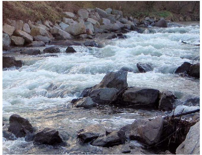
Fig. 6 Les enrochements sur les berges de la Suhre (AG) réduisent fortement les vitesses de l'écoulement. Photo: Denise Weibel
