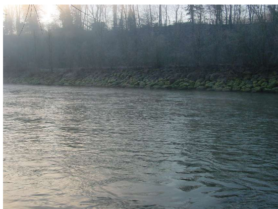
Abbildung 10: begradigte Thur bei Weinfelden.
