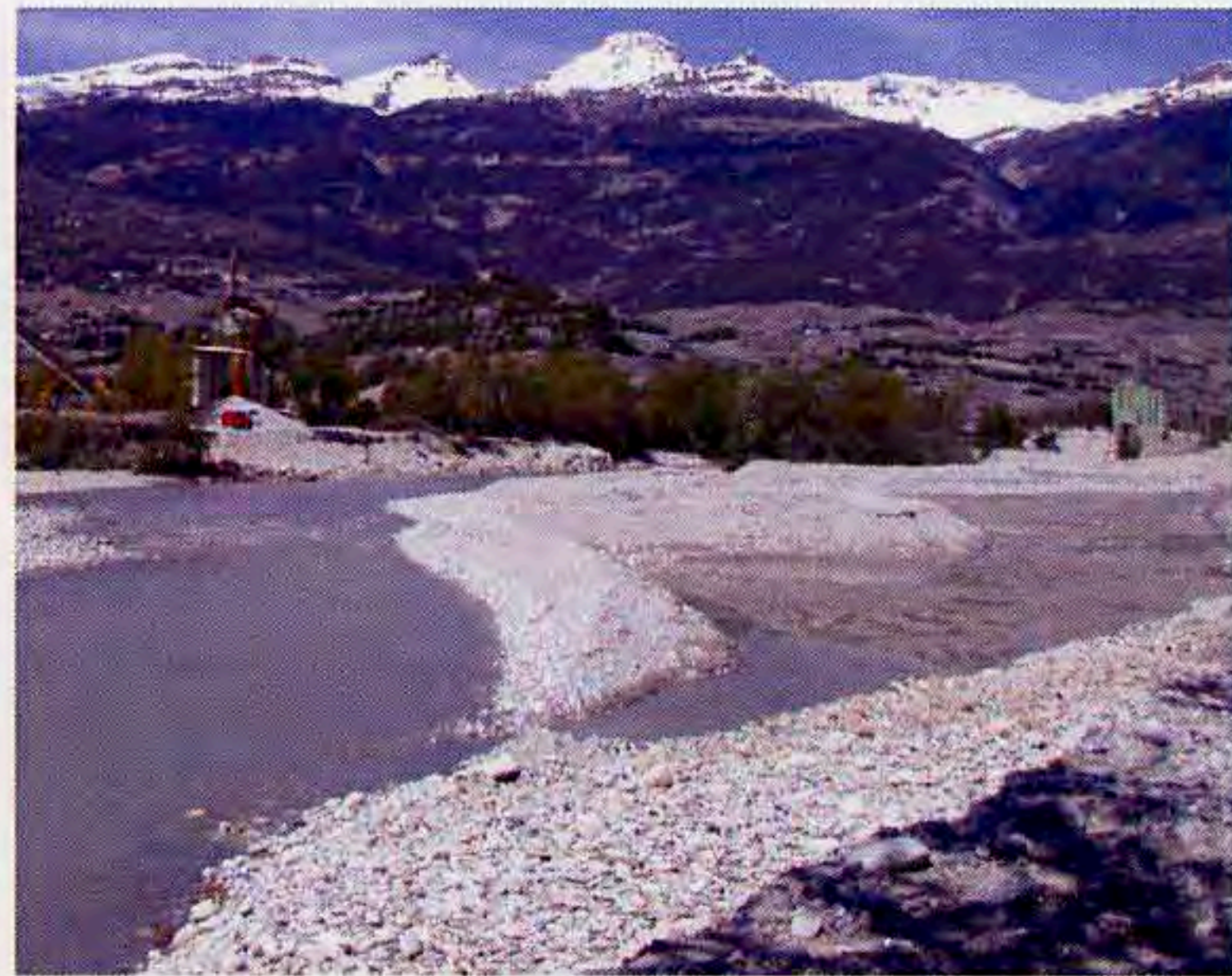
künstlicher Steinwall zur Wasserabtrennung
