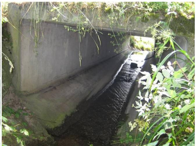
**Abbildung 41:** „Open bottom box“-Verrohrung im Eiholzbach von unten (rechts) und oben (links) gesehen.
