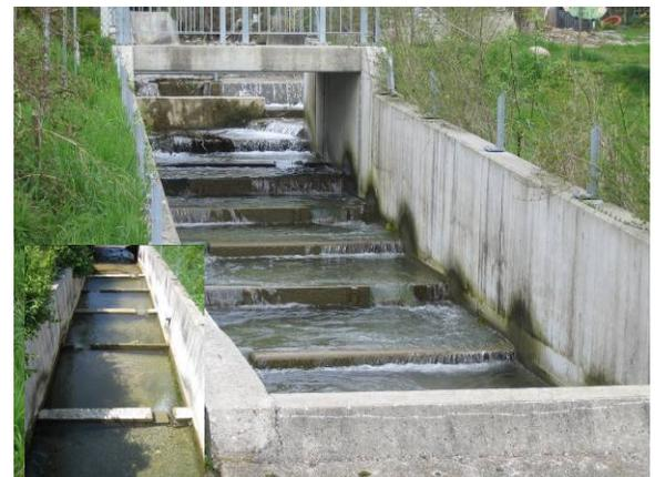
Abbildung 33: Fischpass von unten (grosses Bild) und oben (kleines Bild).
