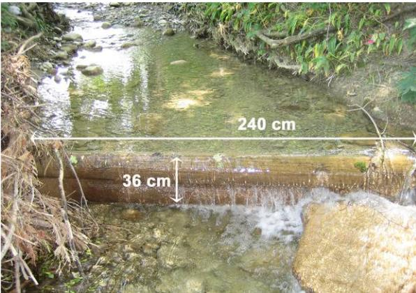
**Abbildung 29:** Gezeigt ist die 36 cm hohe und 240 cm breite Schwelle bei Zellfeld im Chommlibach.
