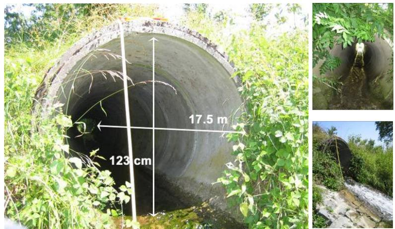
**Abbildung 43:** Verrohrte Mündung des Trienger Dorfbachs, Frontalansicht mit (grosses Bild) und ohne (kleines Bild, oben) Massen und der Anfang der Verrohrung (kleines Bild, unten).
