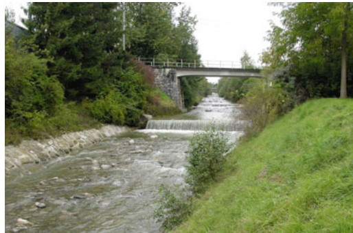
Figure 2.12 : Trème : Ouvrage transversal de stabilisation du fond, septembre 2001 (Photo : L. Hunzinger, Schälchli, Abegg + Hunzinger).
