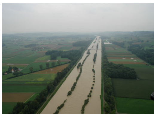
Figure 2.18 : Crue de la Thur à Uesslingen, TG, août 2005. Grâce à une protection efficace contre les crues, aucun dommage n'a été subi (Photo : Police cantonale de Zurich).
