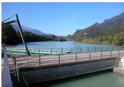
Figure 2.8 : Barrage fluvial dans le Rhin alpin près de Domat-Ems, GR, septembre 2003 (Photo : A. Peter, Eawag).
