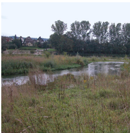
Figure 7.26 : Cours d'eau de contournement de Ruppoldingen, SO, 2004 (Photo : A. Peter, Eawag).
