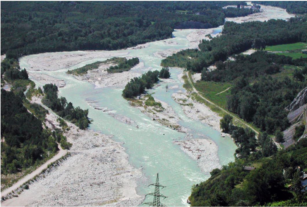
Figure 6.6 : Transferts et échanges de matériaux charriés dans le Rhône au niveau du bois de Finges, VS, août 2001 (Photo : Eawag).
