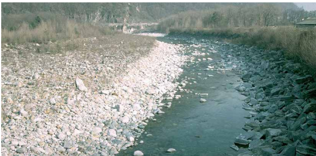
Abbildung 2.13: Sohlenerosion in der Melezza, TI, 1997 (Foto: L. Hunzinger, Schälchli, Abegg + Hunzinger).
