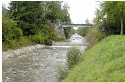
Abbildung 2.12: Trème: Querbauwerke zur Sohlens stabilisierung, September 2001 (Foto: L. Hunzinger, Schälchli, Abegg + Hunzinger).
