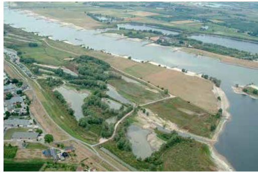
Abbildung 7.22: Neu angelegtes Seitengerinne an der Waal bei Beneden-Leeuwen, Niederlanden, 2003 (Foto: Bert Boekhoven, Niederlanden).
