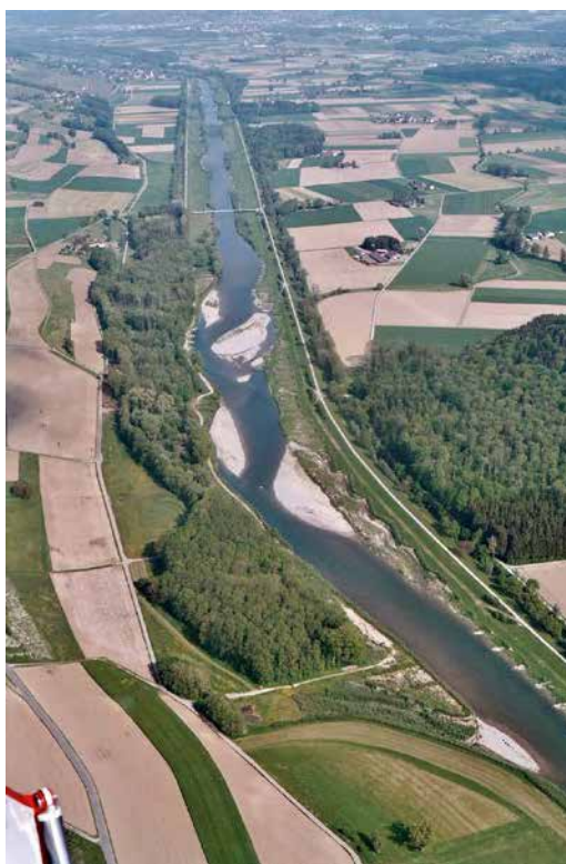
Abbildung 1.1: Revitalisierter Abschnitt der Thur bei Schafftäli als Bestandteil der zweiten Thur-Korrektion (Projektdauer: 1993–2004), TG/ZH, Mai 2004 (Foto: C. Herrmann, BHAtteam, Frauenfeld).
