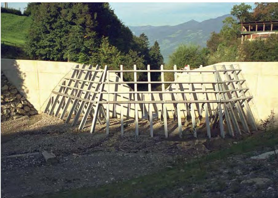
**Bild 3. Geschiebesammler am Dorfbach von Sachseln mit Grobrechen zum Schutz vor Geschwemmseil. Die kleine Durchlassöffnung staut den Sammler schnell ein, sodass die Geschiebedurchgängigkeit bereits bei kleineren Hochwasser nicht mehr gewährleistet ist (Photo Dr. Martin Jäggi).**
