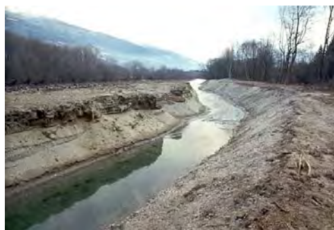
Abbildung 4: In der Niederwasserzeit gebaggertes Nebengerinne.
