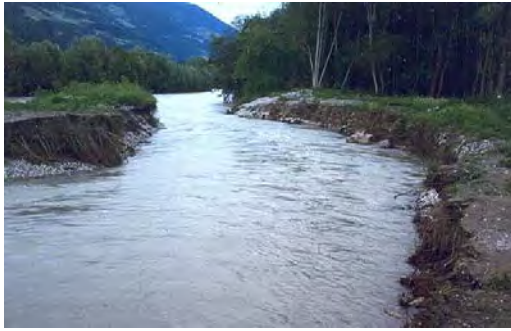
Abbildung 5: Schon beim ersten höheren Wasserstand setzt Seitenerosion ein.
