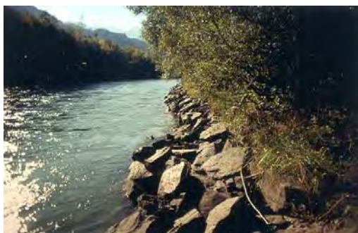
Abbildung 3: Uferverbauung vor den Revitalisierungsmaßnahmen.
