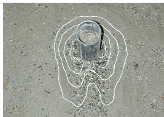
Figure 3: Fosse d'affouillement autour d'une pile
