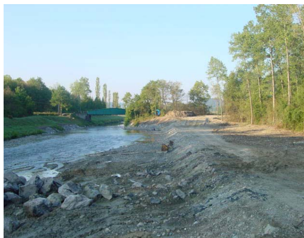
Septembre 2003, zone déversoir
