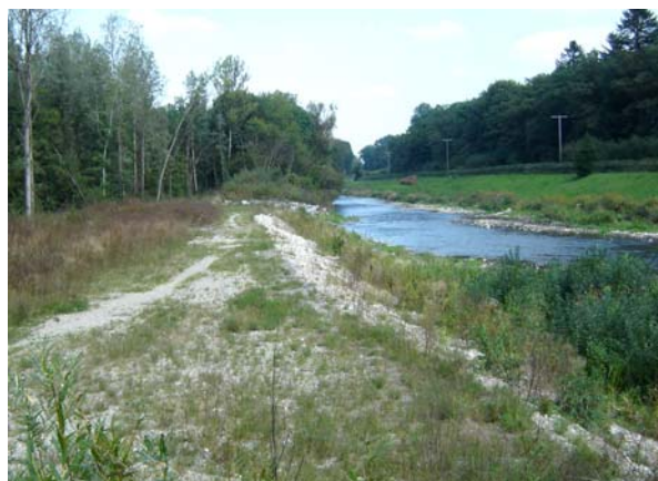
Septembre 2005, zone déversoir
